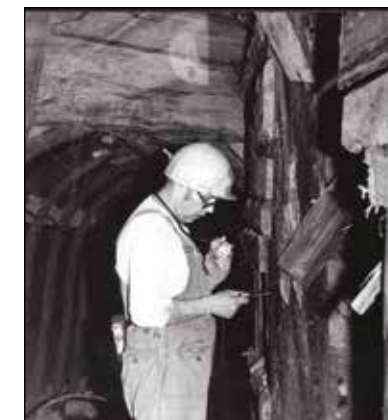
Robert Brož při měření puklin geologickým kompasem, Uhelné doly Příbram, bez datace, foto Renáta Louvarová (Záběhlická) ÚSMH AV ČR, sbírka fotografií
