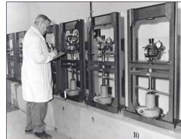
Reologické (dlouhodobé) zkoušky hornin v prostém tlaku na mechanických (pružinových) lisech, Jaromír Houska, bez datace, foto Renáta Louvarová (Záběhlická) ÚSMH AV ČR, sbírka fotografií
