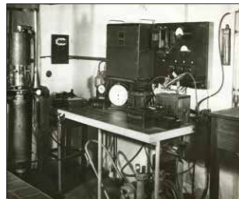
Skupina tepelně-technického výzkumu. Přístroj pro zkoumání zápalu tuhých paliv ve vrstvě. Fotografie z výroční zprávy ústavu za rok 1952 NA, fond MPE, k. 110, inv. č. 84
