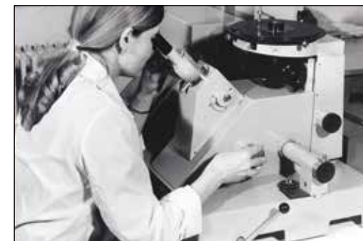
Jadwiga Plocková proměřuje preparát hnědého uhlí v polarizovaném světle (klasiifikace uhlí pro tlakové zplyňování), bez datace, foto Renáta Louvarová (Záběhlická) ÚSMH AV ČR, sbírka fotografií
