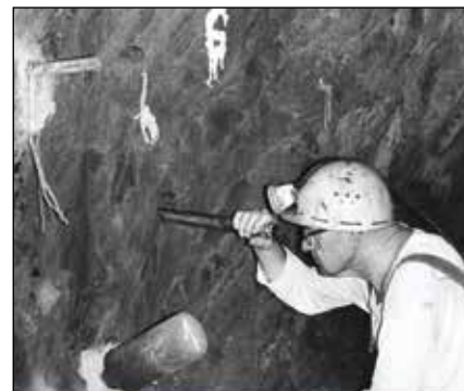
Alois Píkrýl při měření porušenosti horniny pomocí introskopu, Uhelné doly Příbram, bez datace, foto Renáta Louvarová (Záběhlická) ÚSMH AV ČR, sbírka fotografií
