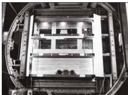
Modelovací stand pro měření rozložení deformací kolem důlních děl, bez datace, foto Karel Fink ÚSMH AV ČR, sbírka fotografií
