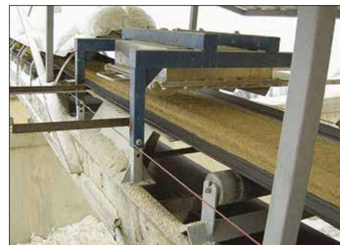
Magnetický odlučovač nečistot nad dopravním pásem surovinové směsi, bez datace, foto autor neuveden ÚSMH AV ČR
