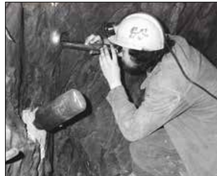
Měření porušenosti horniny pomocí introskopu, Uhel-né doly Příbram, na snímku J. Přidal, zaměstnanec Uhel-ných dolů Příbram, bez datace, foto Renáta Louvarová (Záběhlická) ÚSMH AV ČR, sbírka fotografií
