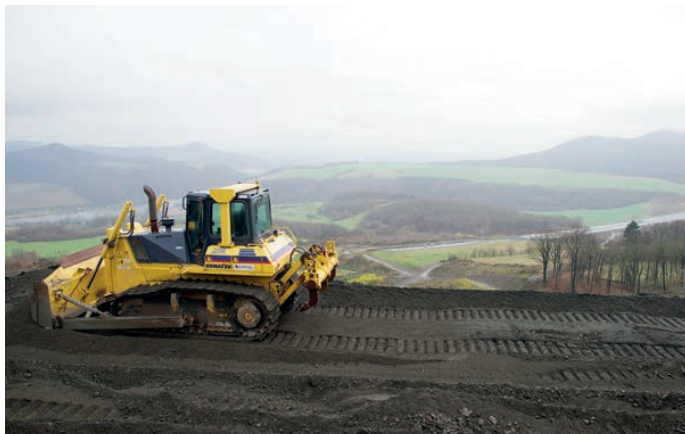
Při likvidaci velkého závalu u Dobkoviček bylo potřeba odklidit tisíce tun hlíny a kamení
