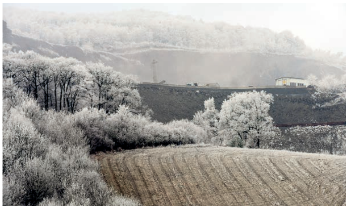
Svah zabezpečený proti dalšímu posuvu vypadá opravdu pěkně. Aby ne, za ty stovky milionů...
